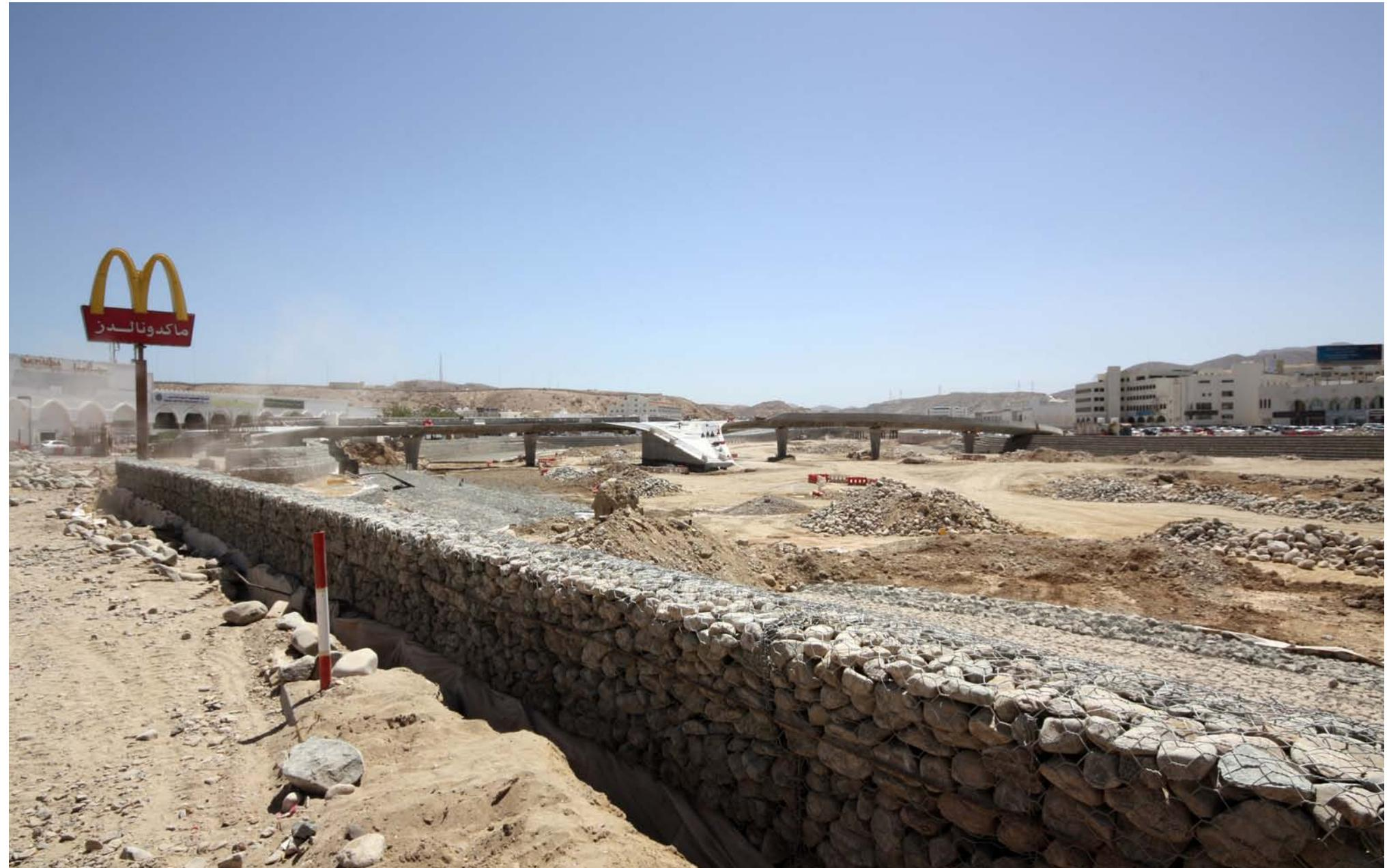
**Neubau der Kanalisierung des Wasserabflusses in Qurum als Reaktion auf die Überflutungen von 2007 (Zyklon Gonu) und 2010 (Sturm Phet)**
