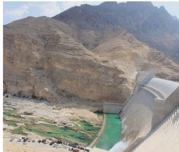
**Daykah-Damm (100 km südlich von Maskat) wurde 2012 in Betrieb genommen und entspricht mit einer Länge von 400 Metern und einer Höhe von 74 Metern ungefähr dem geplanten neuen Damm im Wadi Samail**
