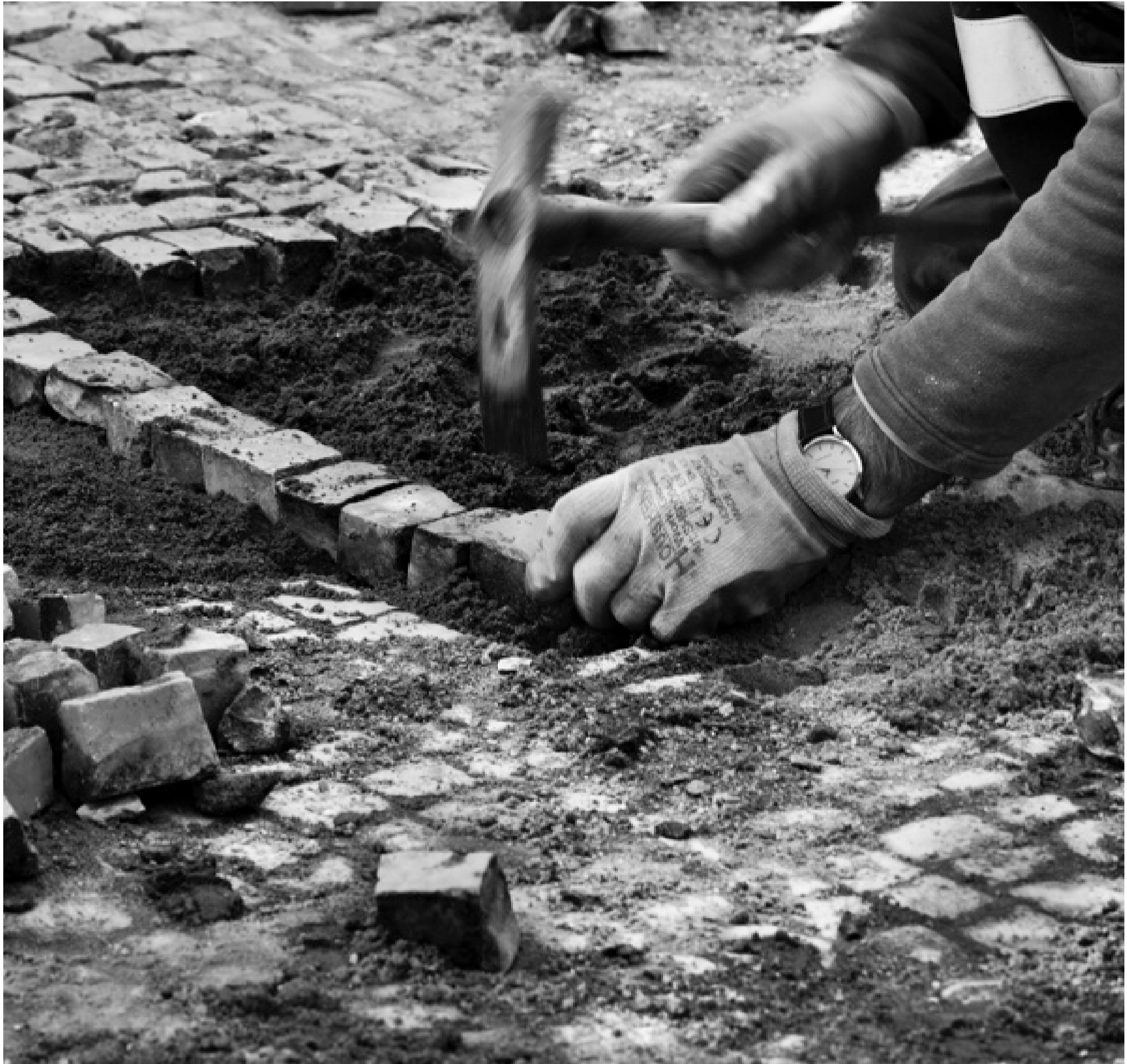
Handwerker arbeitet an einer Calçada in Lissabon © Isabel Pinto
