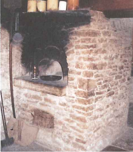
BACKOFEN IN DER KÜCHE (Bsp. La Chaux-de-Fonds NE)
