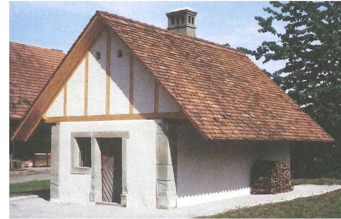
OFENHAUS RIZENBACH nach der Instandsetzung
