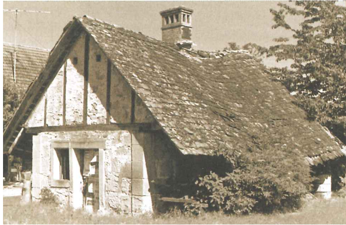
OFENHAUS RIZENBACH vor der Instandsetzung
